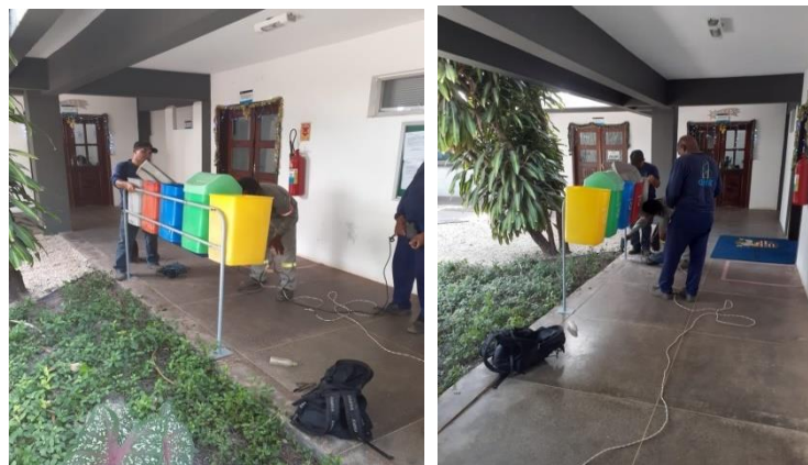
Figura 2: Instalação de coletores seletivos no corredor do prédio.
