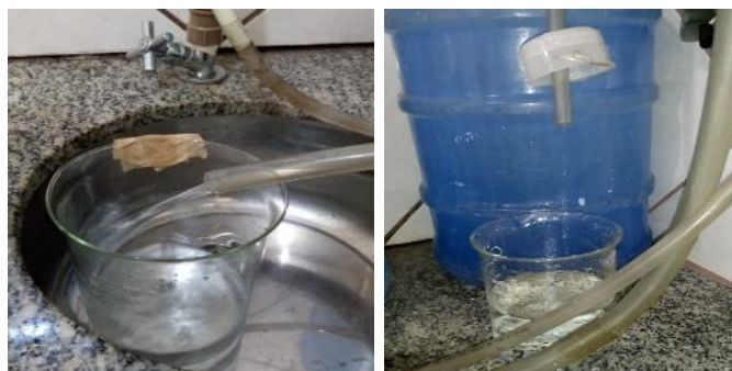
Figura 1 - Monitoramento do desperdício de água do destilador instalado no prédio de Química e Ciências, Campus Paulo VI, para a obtenção de dados.
