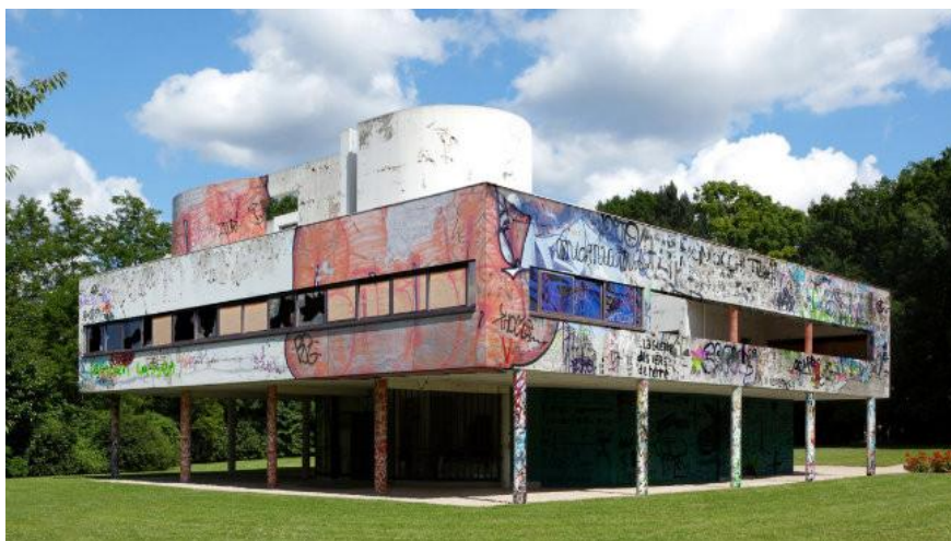
Figura 2: Villa Savoye Vandalizada
